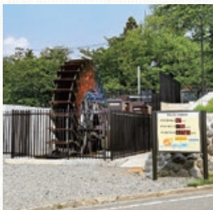
常西公園小水力発電所
